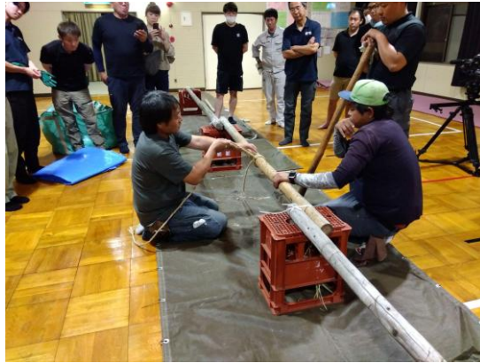
写真（左）茅を押えるヌイボクをわら縄で締め上げる場面の説明
