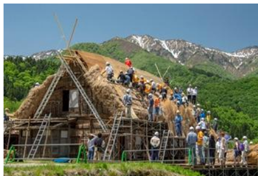
結による屋根葺き替え
