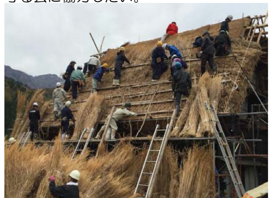
【結による屋根葺きを継続実施】
