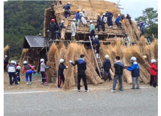
【裏面表面から同時に屋根葺き】
