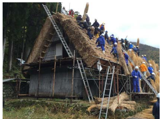
[旧松井家の結による屋根葺き]
