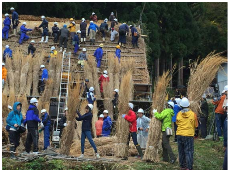
【参加者の総力で屋根の葺き替え】
