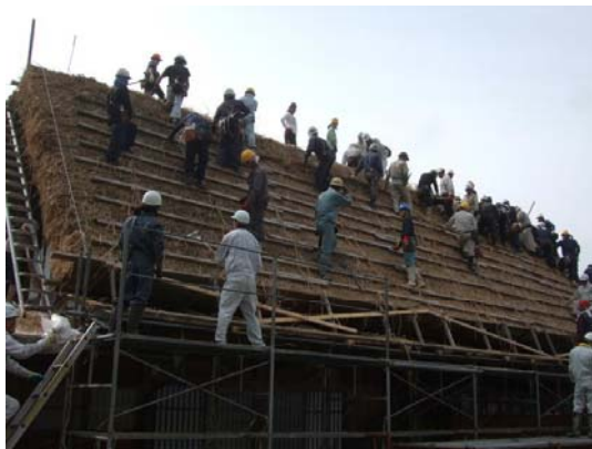
[上手家の結による屋根葺き]
