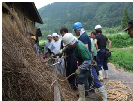
【仮設屋根を組んで屋根葺き体験】
