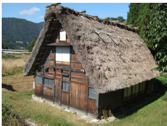
【合掌文化館(旧松井家)東面の屋根】
