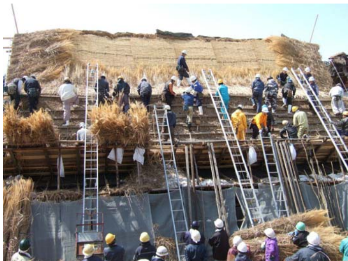
【結で行われた屋根の葺き替え】
