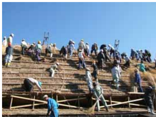
[上手家の結による屋根葺き]
